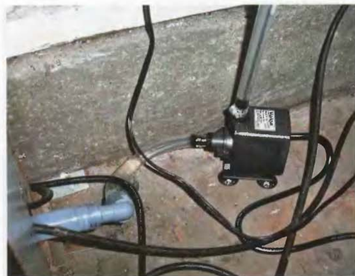
Насосы бывают разные. Чаще всего это насосы погружного типа, но встречаются и другие варианты. Простое решение – аквариумная помпа.
