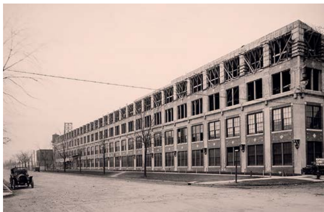
Строительство автомобильного завода «Паккард» — первого полностью возведённого по новой технологии, предложенной братьями Кан
