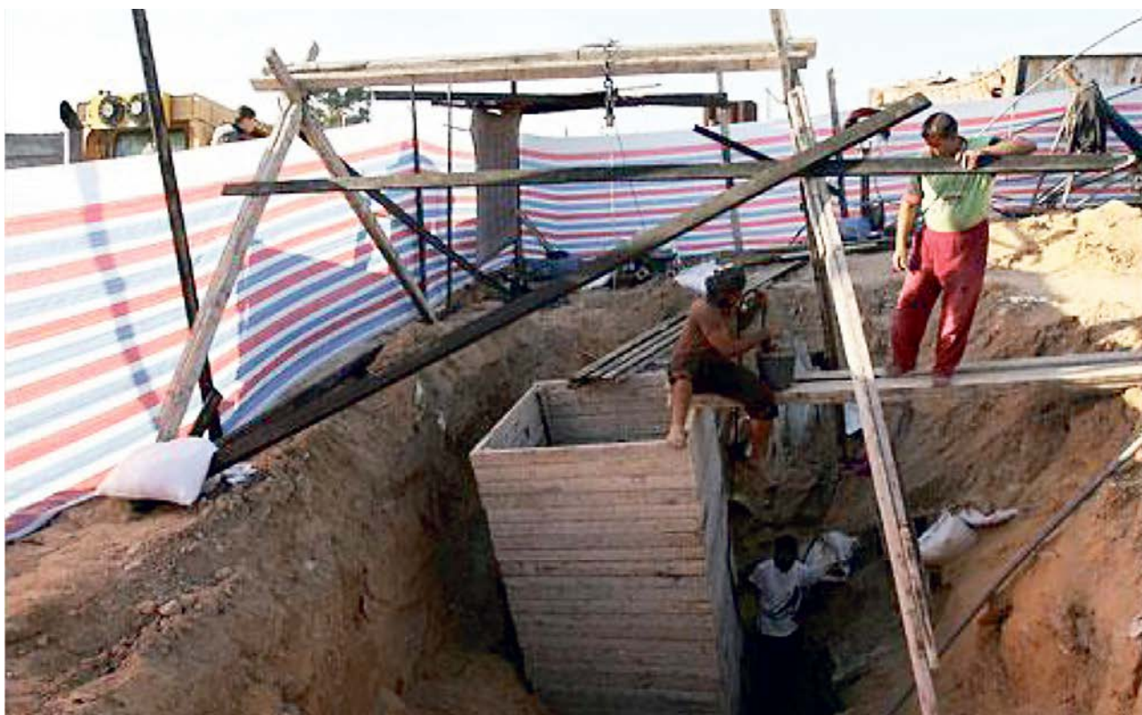
Строительство ствола доступа к контрабандному туннелю
