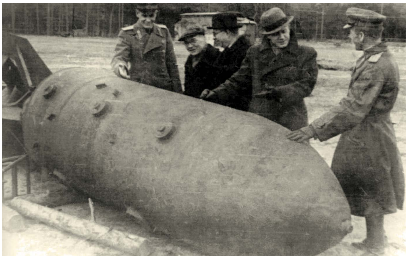
Авиабомба ФАБ-5000НГ. Диаметр — 1 м, длина — 5,2 м, масса бомбы — 5400 кг, масса ВВ — 3200 кг.
