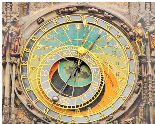
Астрономический циферблат Пражского Орля показывает четыре часовых измерения (старочешское, центральноевропейское, планетарное, звёздное)
