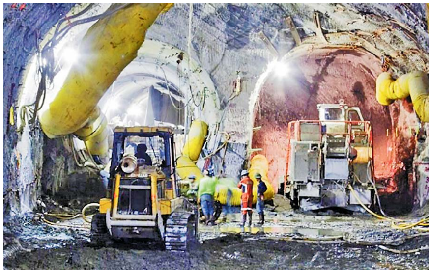
Рис. 17. Сложный узел соединения туннелей с повышенным риском обрушения пород.
