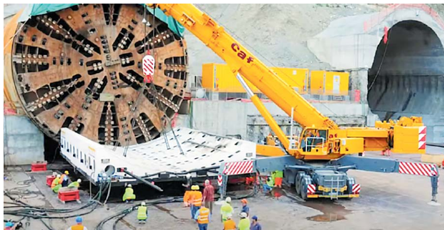
Рис. 16. Монтаж буровой туннельной машины Herrenknecht с диаметром щита 15,55 м в туннеле Спарво, Италия.
