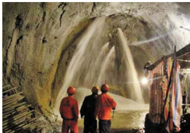
Рис. 28. Высоконапорный и объёмный прорыв воды в процессе экскавации туннеля.
