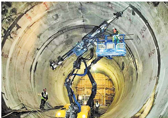
Рис. 32. Горизонтальный тампонаж закрепного пространства туннеля.
