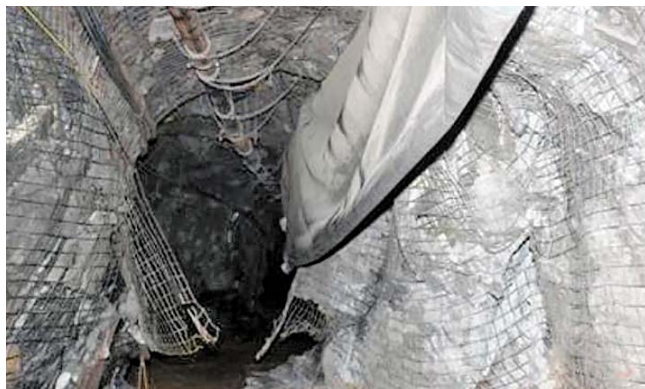
Рис. 3. Очень тяжёлое выдавливание. 30_Varden%20.pdf
