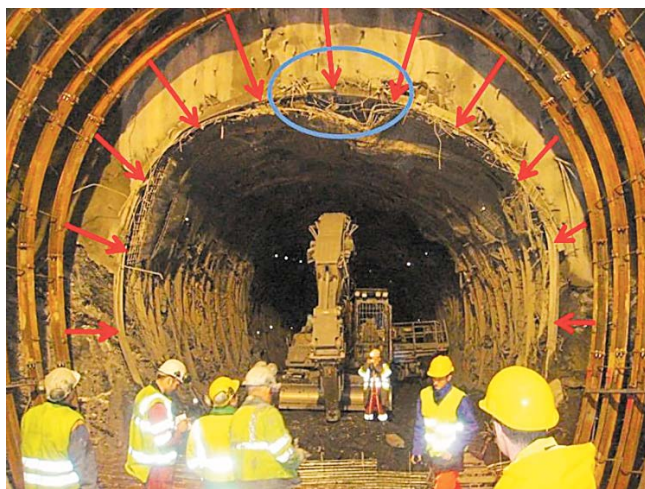
Рис. 1. Сжатие пород уменьшает сечение туннеля.
