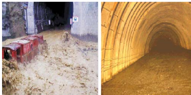
Рис. 29. Затопление туннеля при прорыве воды.
