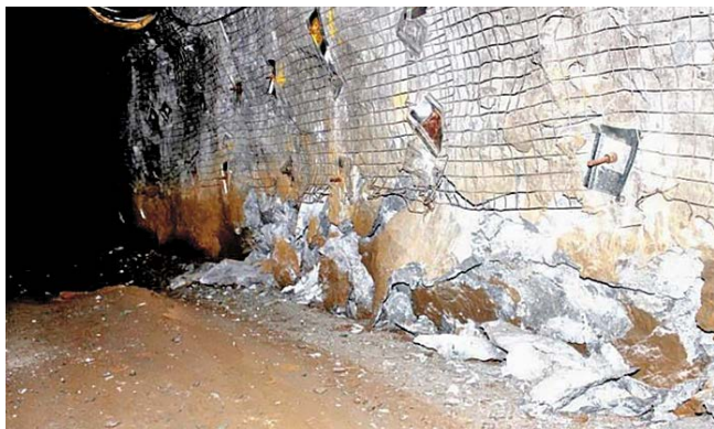
Рис. 2. Малое выдавливание. 30_Varden%20.pdf
