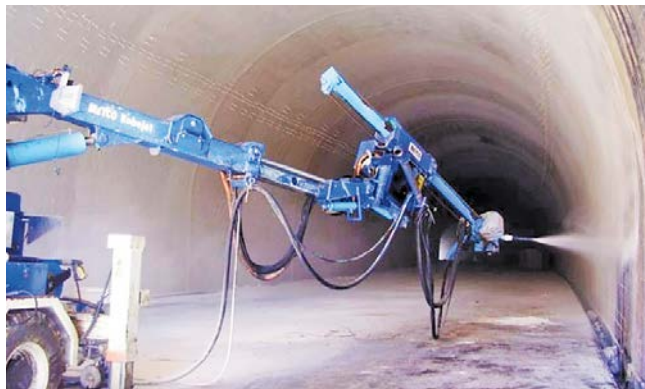
Рис. 25. Применение набрызгбетона для временной крепи туннеля.
