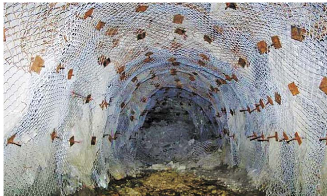
Рис. 22. Туннель, закреплённый анкерными болтами и металлической сеткой.
