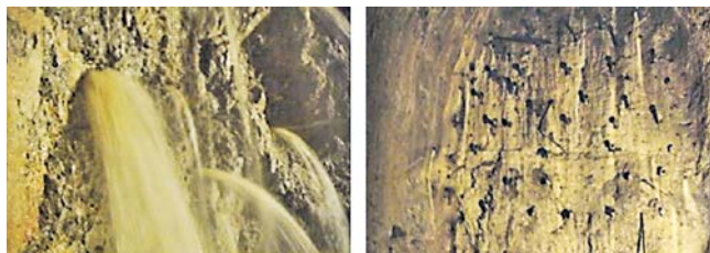
Рис. 31. Результат предварительной цементации водоносной зоны.
