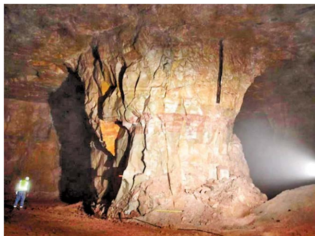
Рис. 9. Разрушение целика в известняковой шахте Пенсильвании.
