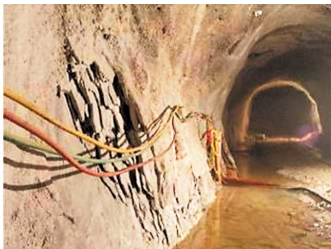
Рис. 6. Расслоение поверхности пород туннеля проекта Цзиньпин II при слабом выбросе.
