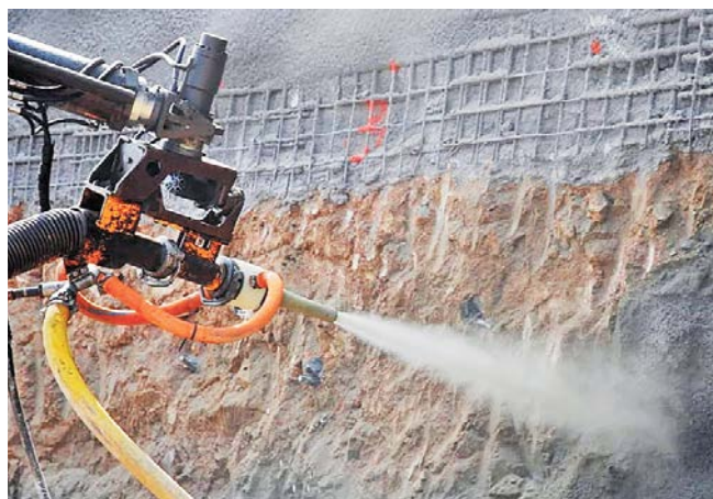
Рис. 17. Набрызг-бетонная крепь полостей CERN.
