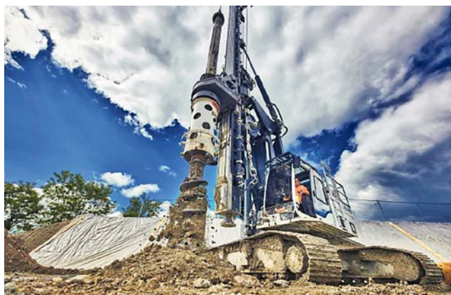
Рис. 25. Начало проходки новых вертикальных стволов пунктов 1 и 5. https://home.cern/resources/faqs/civil-engineering-work-high-luminosity-thc
