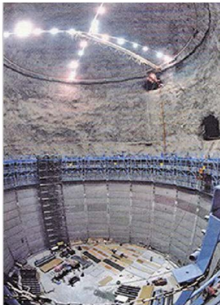
Рис. 7. Строительство полости детектора лаборатории Супер-Камиоканде.
