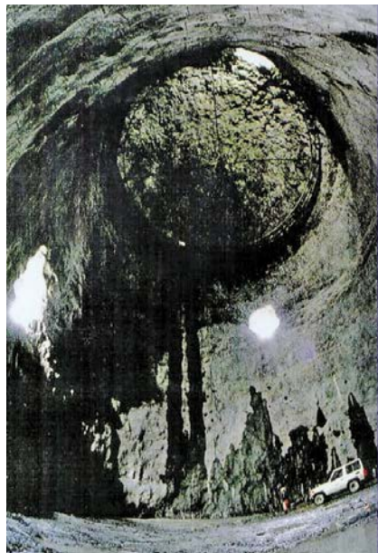
Рис. 7. Строительство полости детектора лаборатории Супер-Камиоканде.
