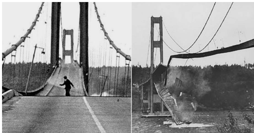
Такомский мост (США, штат Вашингтон) рухнул в 1940 году из-за порывов ветра, в резонанс раскачавших сооружение
