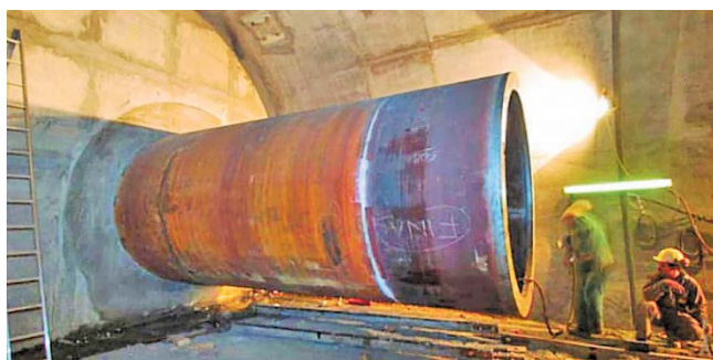
Рис. 27. Установка трубы доступа в туннеле. https://proj-cngs.web.cern.ch/PDF_files/KElsener_LNGS_medium_2April04.pdf
