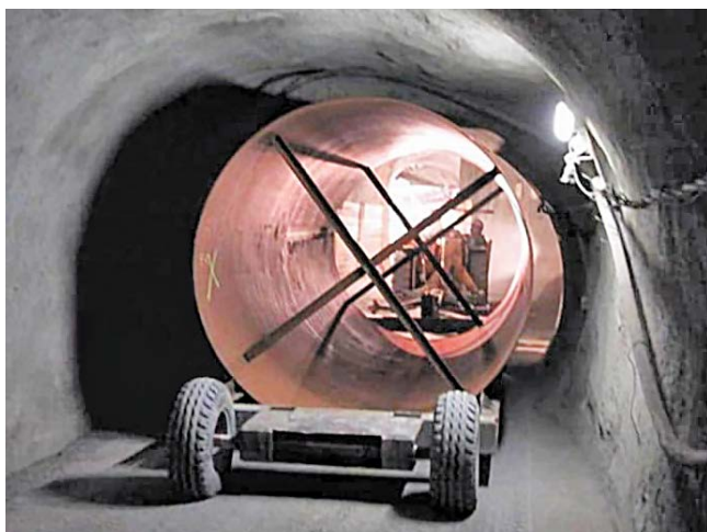
Рис. 26. Подземная транспортировка трубы доступа (длина секции 18 м). CNGS_for_CERNguides29June2006
