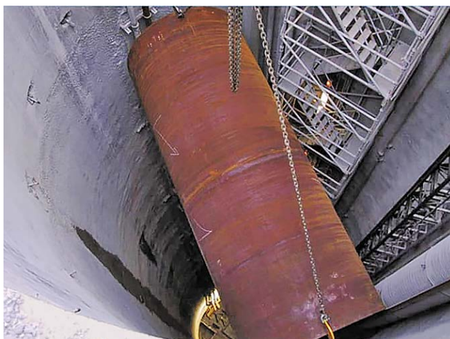
Рис. 25. Спуск трубы туннеля распада по стволу доступа (длина секции трубы 6 м). CNGS_for_CERNguides29June2006
