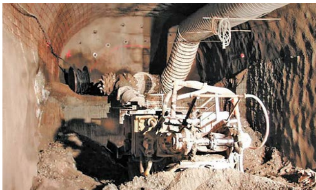
Рис. 21. Проходка туннелей проходческим комбайном с вращающейся головкой.
