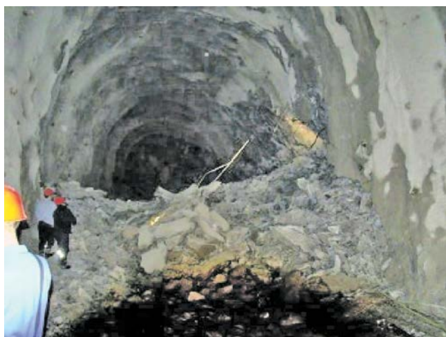
Рис. 16. Последствия внезапного выброса пород в туннеле.
