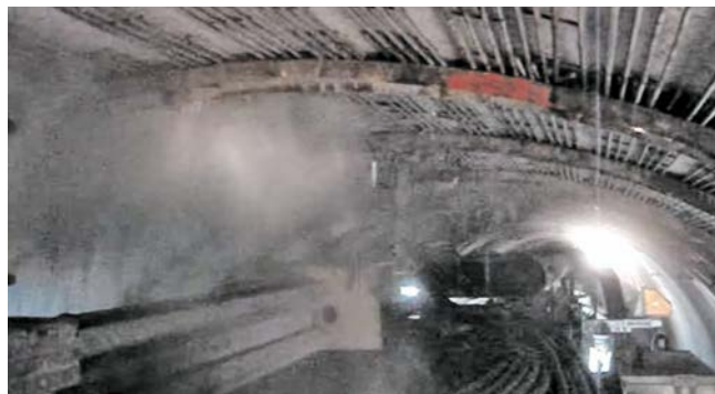
Рис. 15. Внезапный выброс пород в туннеле Олмос.
