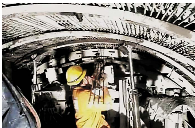
Рис. 13. Установка металлических стержней в «карманы». https://www.robbsintbm.com/ground-support-for-high-cover-tunnels-what-is-the-best-method/
