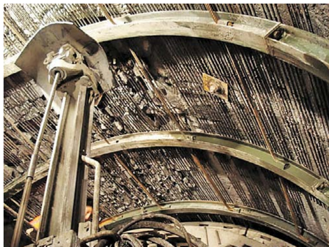
Рис. 11. Туннель Олмос, закреплённый системой McNally. https://www.tunneltalk.com/TBM-Recorder-Jan12-TBM-conquers-Andes-at-Olmos.php
