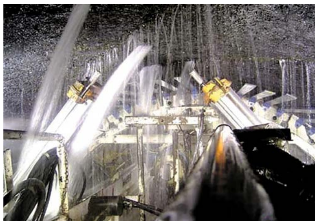
Рис. 22. Аварийный приток воды в туннель Олмос во время работы буровой туннельной машины.
