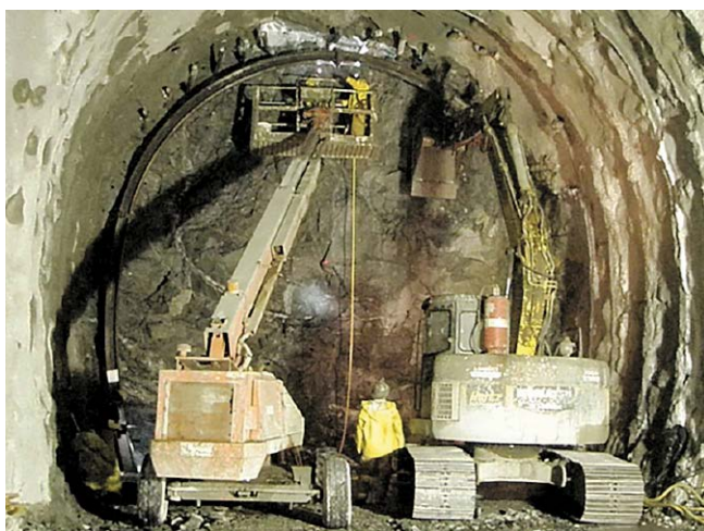
Рис. 13. Установка металлической крепи в забое начального (стартового) туннеля.
