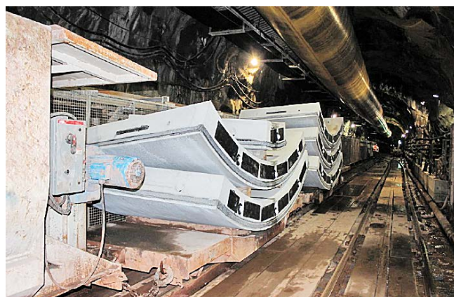
Рис. 20. Комплект кольца сегментной крепи на платформе доставки к забою туннеля.
