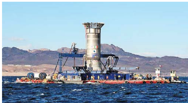
Рис. 22. Собранная на барже металлическая конструкция водозаборного узла № 3.
