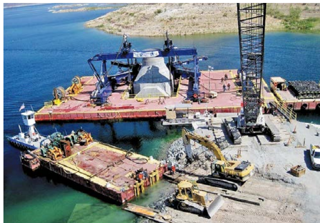
Рис. 21. Погрузка на баржу и сборка водозаборного узла № 3.
