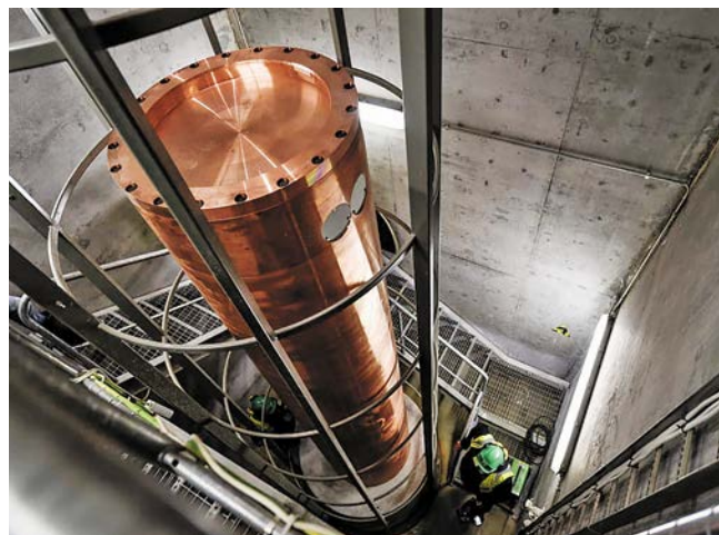
Рис. 8. Медный контейнер с отработанным ядерным топливом погружается в камеру.
