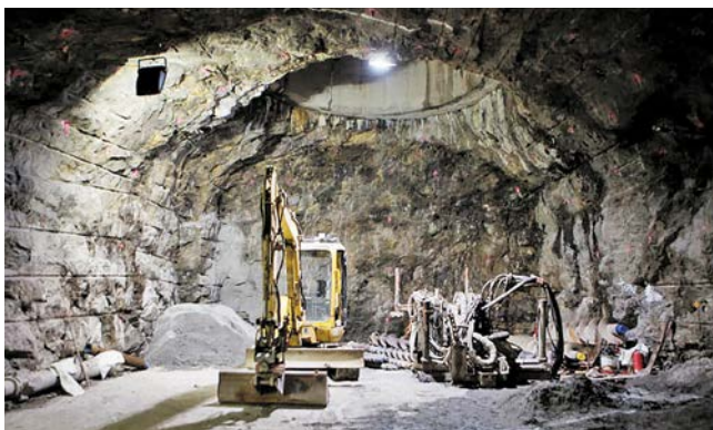
Рис. 5. Эскавационные работы в туннеле хранилища Онкало.
