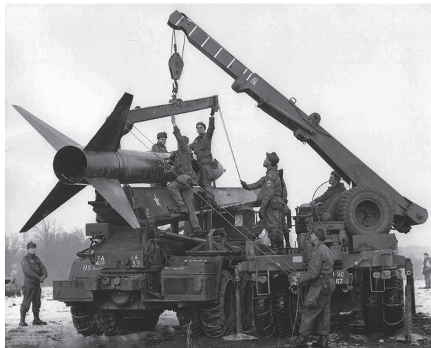
Заряжание пусковой установки ракеты «Онест Джон»
