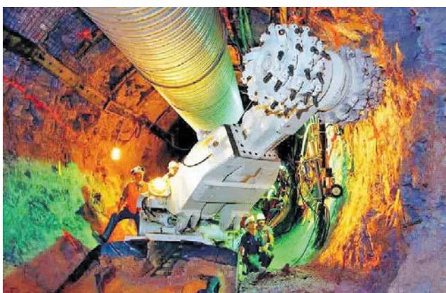
Рис. 15. Работа комбайна избирательного действия при проходке разведочного туннеля в Юкка-Маунтин.
