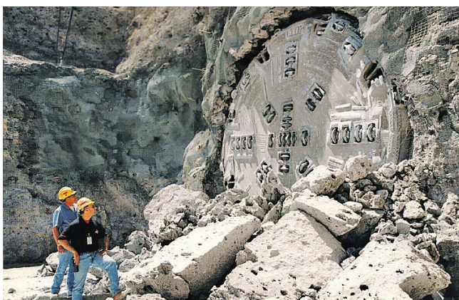
Рис. 14. Окончание проходки разведочного туннеля буровой машиной.
