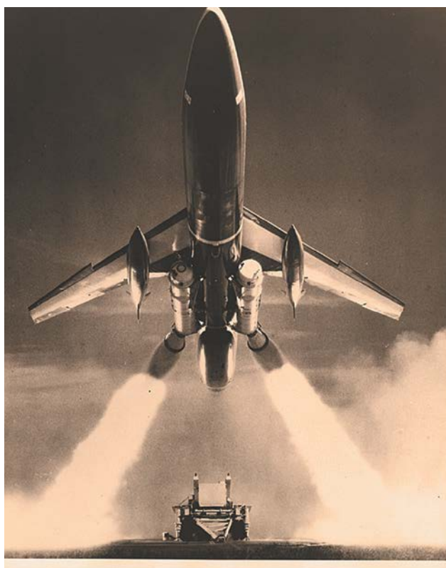
Старт ракеты SM-62 «Снарк». Ракета имеет подвесные топливные баки
