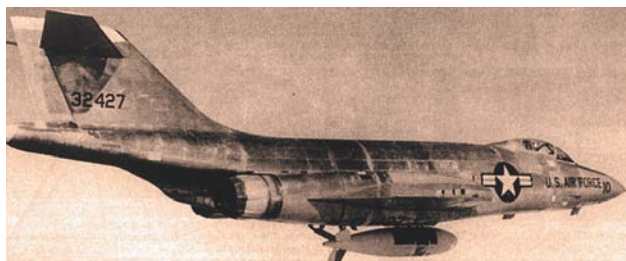
Истребитель F-101C «Вуду», оборудованный для применения бомбы Mk-7. В составе Тактического командования ВВС США была одна эскадрилья таких самолётов
