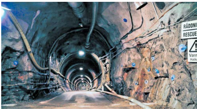
Рис. 13. Анкерная крепь туннеля в хранилище радиоактивных отходов.
