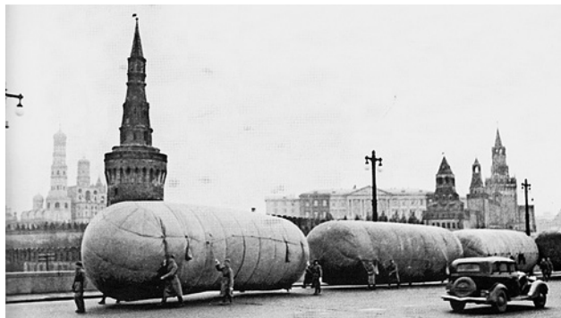
Газгольдеры для заправки аэростатов воздушного заграждения на Москворецком мосту. 1941 г. (Автор: Наум Грановский)
