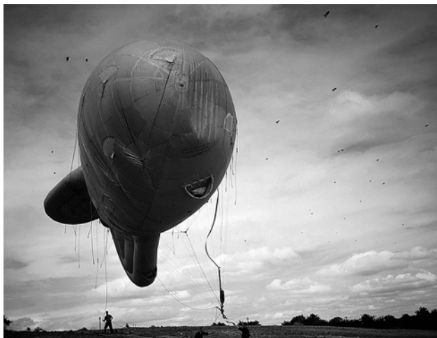
Британский заградительный аэростат, используемый для защиты Лондона от немецких крылатых ракет ФАУ-1 (V-1, Fi 103). 1944 г.
