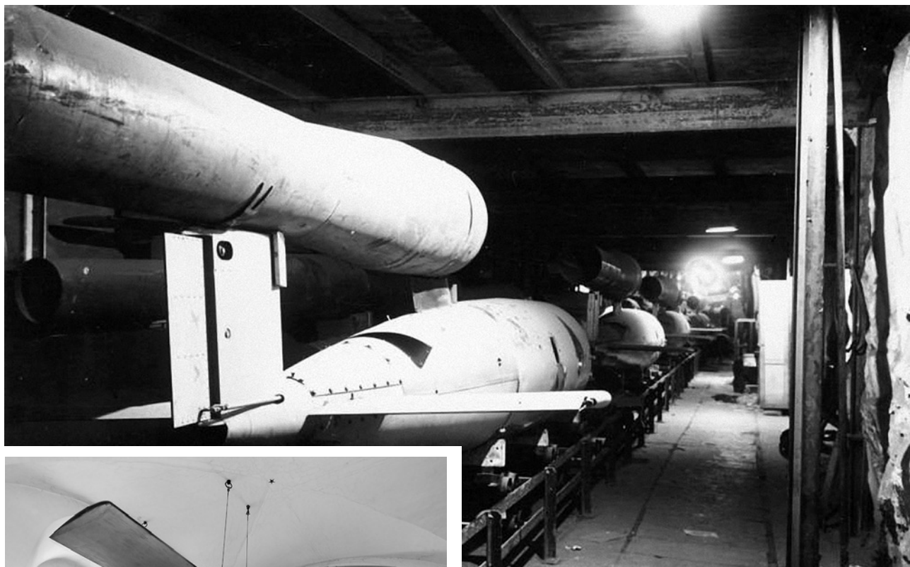
Конвейер на подземном заводе по сборке самолёта-снаряда ФАУ-1 (V-1). Германия, 1945 г.
