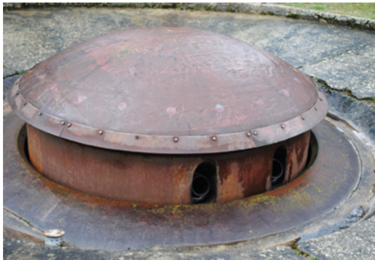
Поднимающаяся артиллерийская бронебашня линии Мажино
