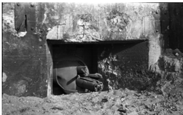
Артиллерийский полукапонир линии Сталина. Ствол орудия срезан на металлолом
