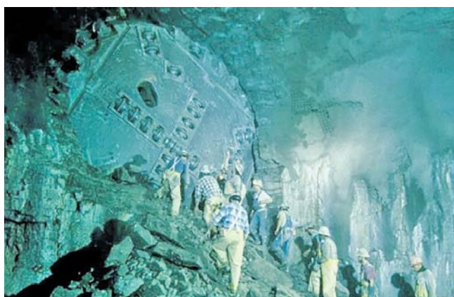
Рис. 4. Момент соединения туннелей буровой туннельной машиной
