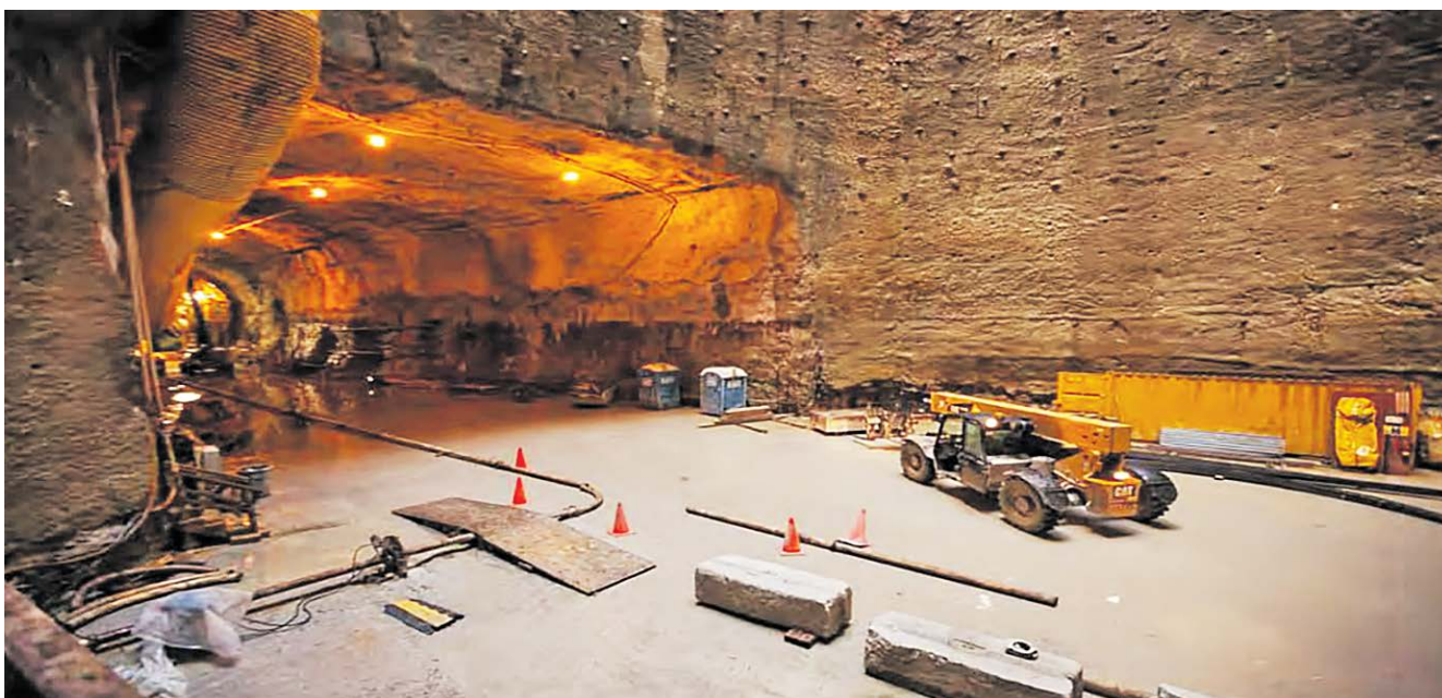
Рис. 16. Строительство полости для герметических ворот туннеля резервуара McCook https://tunnelingshortcourse.com/2017-presentations/hirner-chicago-tunneling.pdf
