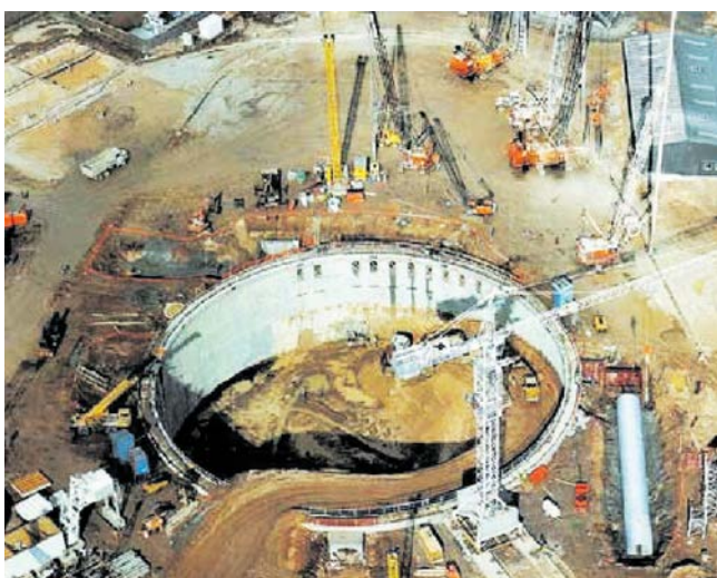
Рис. 10. Один из вариантов проходки ствола доступа к туннелю http://www.planete-tp.com/en/invisible-works-essential-and-complex-r178.html
