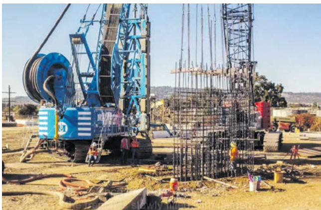
Рис. 11. Установка крепи методом «стена в грунте» при проходке ствола доступа к туннелю ClearwaterProjectLA/videos/1178231749042800
