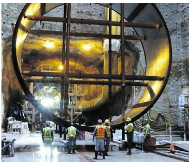
Рис. 19. Установка крепи диаметром 6,6 м в туннеле, примыкающем к резервуару McCook https://national-welding.com/wp-content/uploads/resources/Steel-Tunnel-Liner-McCook-33-Foot-Dia-Main-Line-Bifurcation-for-the-Chicago-TARP-IL.pdf
