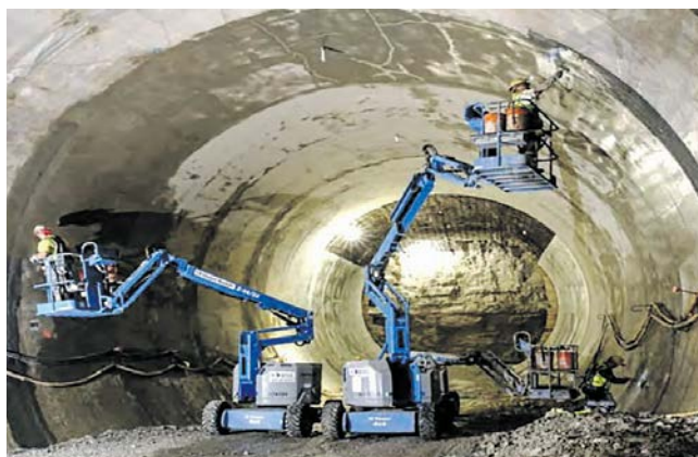
Рис. 6. Набрызгбетонные работы в туннеле
