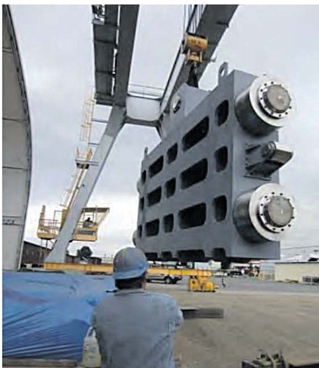
Рис. 17. Спуск к туннелю герметических ворот, которые дают возможность гидравлически контролировать туннели, управлять системами и оптимизировать хранение воды https://tunnelingshortcourse.com/2017-presentations/hirner-chicago-tunneling.pdf
