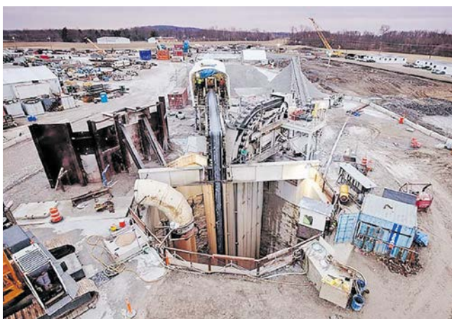
Рис. 9. Ленточный конвейер (фирмы «Роббинс») в вертикальном стволе доступа к туннелю https://www.tunneltalk.com/Discussion-Forum-Apr2015-TBMs-plus-continuous-conveyors-form-a-speedy-combination.php
