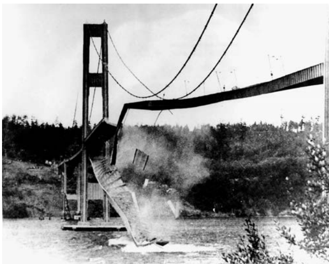
Разрушение моста Такома-Нэрроуз
