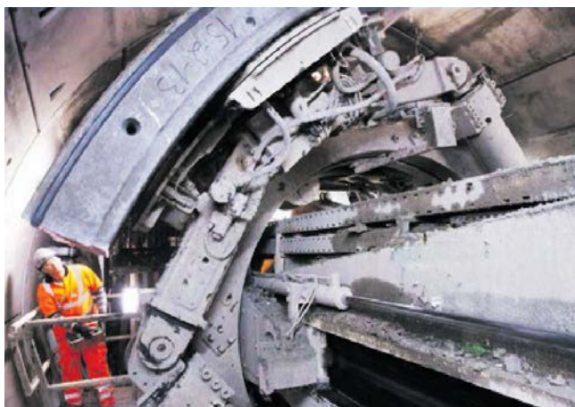
Рис. 22. Укладка бетонных сегментов крепи в туннеле https://www.tunneltalk.com/TunnelTECH-Apr2016-Segment-design-code-of-practice.php
