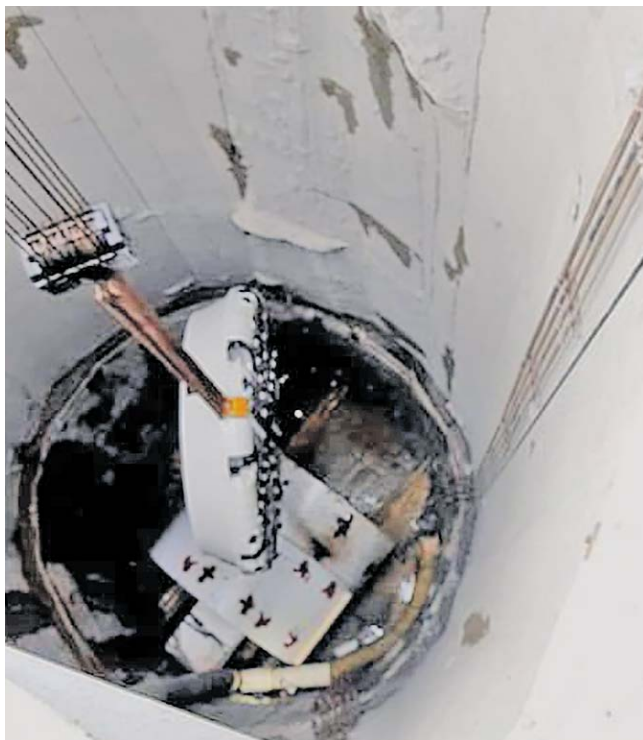
Рис. 16. Спуск буровой туннельной машины по стволу доступа https://www.tunneltalk.com/USA-172020-Project-Clean-Lake-completes-second-of-seven-deep-storage-tunnels-in-Cleveland.php
