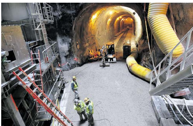
Рис. 13. Камера монтажа буровой туннельной машины в туннеле Эвклид Крик https://barchip.com/euclid-creek-starter-and-exit-tunnels/
