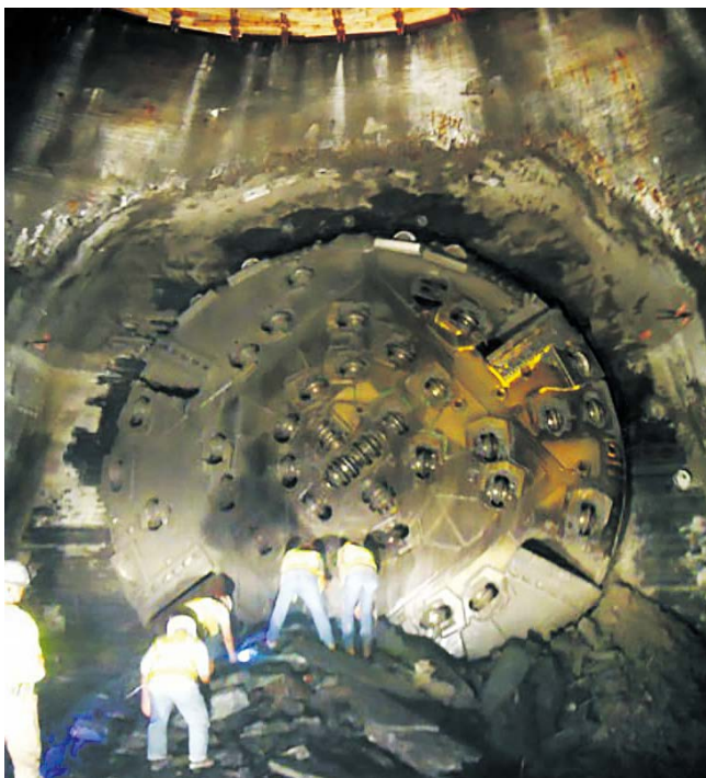
Рис. 12. Работа буровой машины в туннеле Эвклид Крик https://tunnelingonline.com/euclid-creek-tunnel-cleveland/
