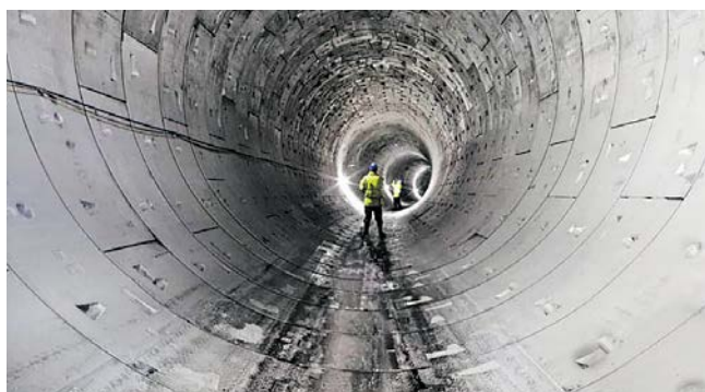
Рис. 23. Туннель, закреплённый бетонными сегментами https://www.tunneltalk.com/Fibrecrete-Oct10-20-years-of-fibrecrete-in-the-UK.php
