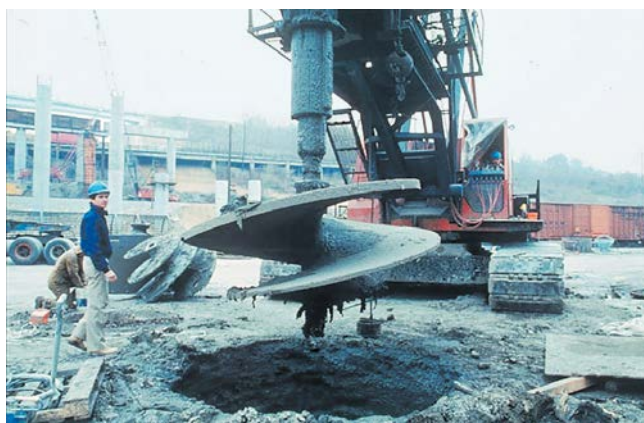
Рис. 10. Шнековое бурение ствола
