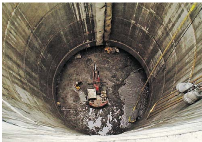
Рис. 24. Ствол доступа, пройденный с помощью кессона https://www.tunneltalk.com/Detroit-outfall-Nov01-Set-up-for-Detroits-outfall-2.php
