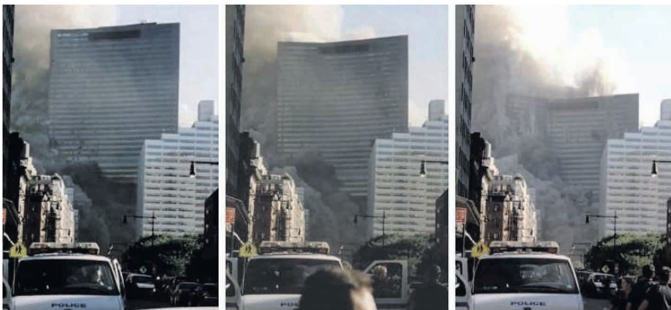
Прогрессирующее обрушение башни №7
