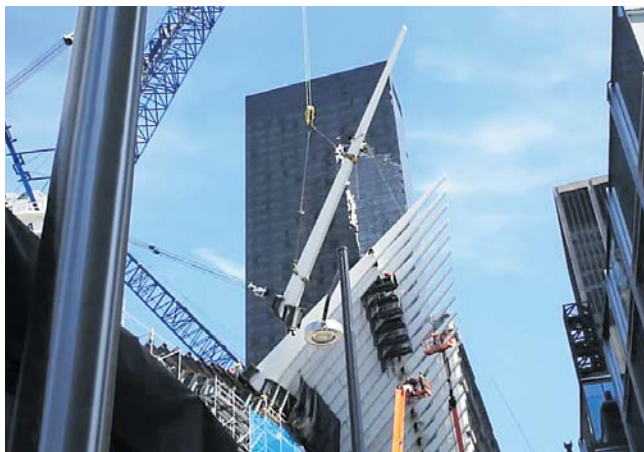
Рис. 19. Монтаж балочных конструкций «крыльев» здания «Окулус».
