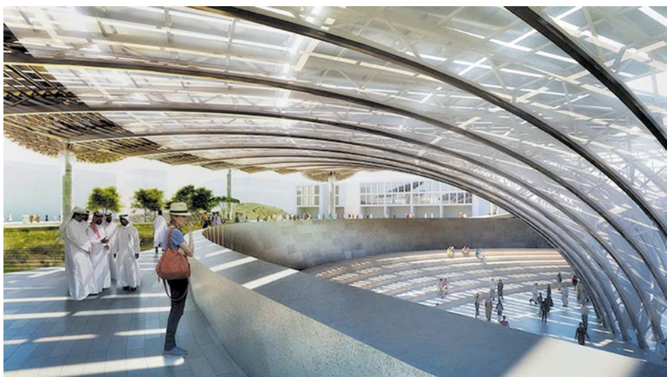
Арочная конструкция крыши не только создаёт тень, но и генерирует энергию
