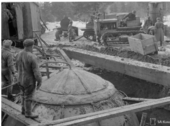
Рис. 21 Строительство ДОТа американским способом
