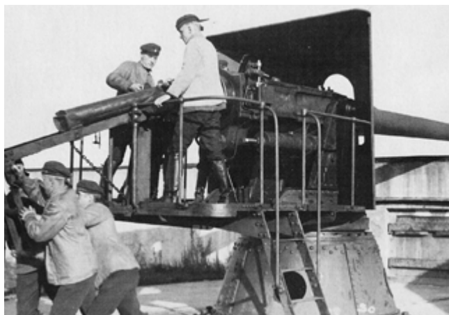
Рис. 106 Редкий кадр. Унитарное заряжание 152/45-мм береговой пушки Кане
