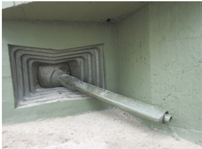
Рис. 29 85-мм казематная пушка ЗИФ-26ЗИФ-26. (Фото А. Широкограда)
