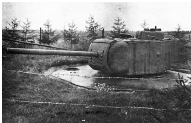
Рис. 42 ДОТ с башней от танка Т-220
