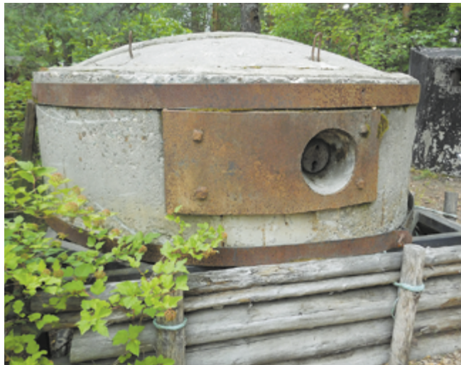
Рис. 3 Железобетонный пулемётный ДОТ, защита усилена бронебойной плитой. (Фото А. Широкограда)
