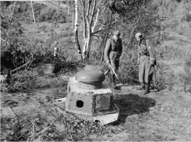
Рис. 11 Финны осматривают ДОТ на КаУРе с башней от танка МС-1
