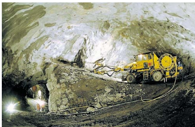
Рис. 20. Экскавация купола верхнего уровня полости хранилища Скаллена. https://www.diva-portal.org/smash/get/diva2:1221714/FULLTEXT01.pdf
