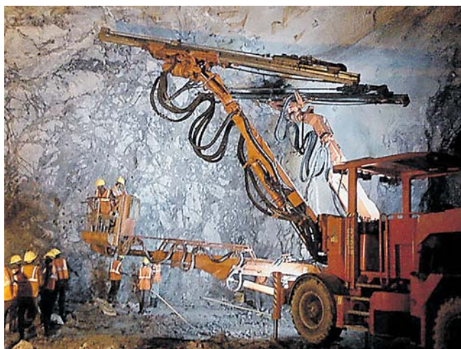
Рис. 15. Бурение скважин для взрывания в полости Падур. http://www.keltechenergies.com/project-1.html
