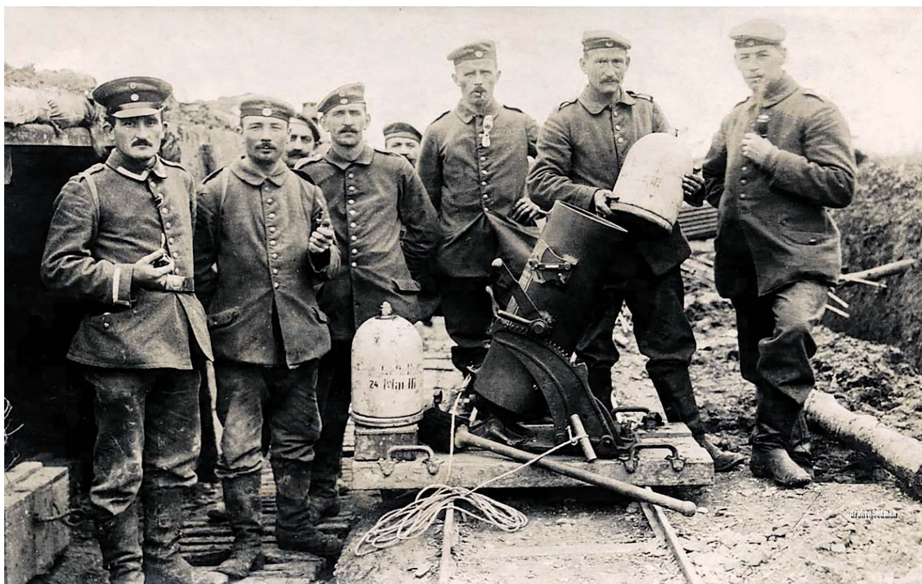
Германский 24-см тяжёлый миномёт Эрхарда, созданный по жёсткой схеме, без противооткатных устройств. Фото 1916 года
