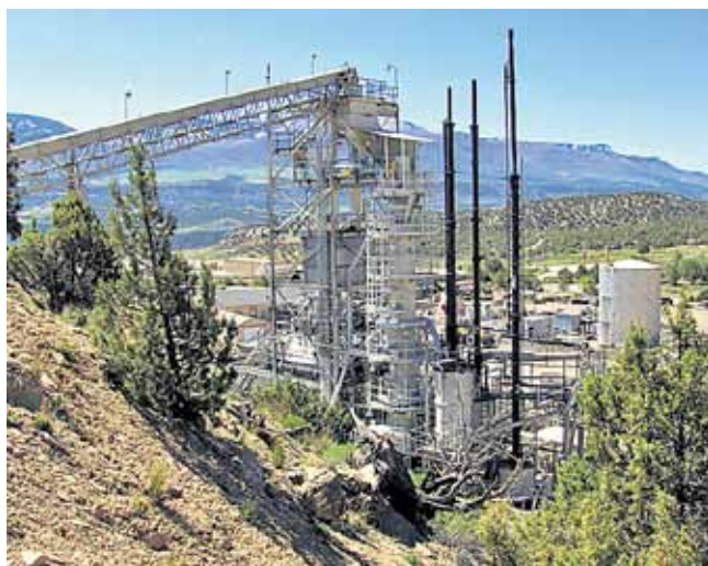
Рис. 4. Реторта конвертации керогена сланцев в нефть и газ. http://oilshaleassoc.org/technology/
