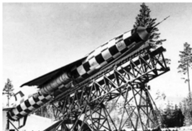
Макет ракеты П-20 во время бросковых испытаний. Начало 1960 г.
