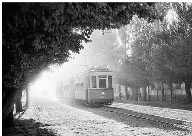
Поезд из узкоколейного моторного трамвая «Х» и двух прицепных «М» в Ташкенте. Производство узкоколейных «Х» прекратилось в середине 30-х — с тех пор СССР трамваи метровой колеи только импортировал. Фотография Макса Пенсона. http://www.maxpenson.com/
