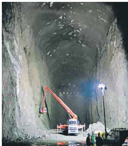
Рис. 15. Строительство полости хранения опасных материалов
