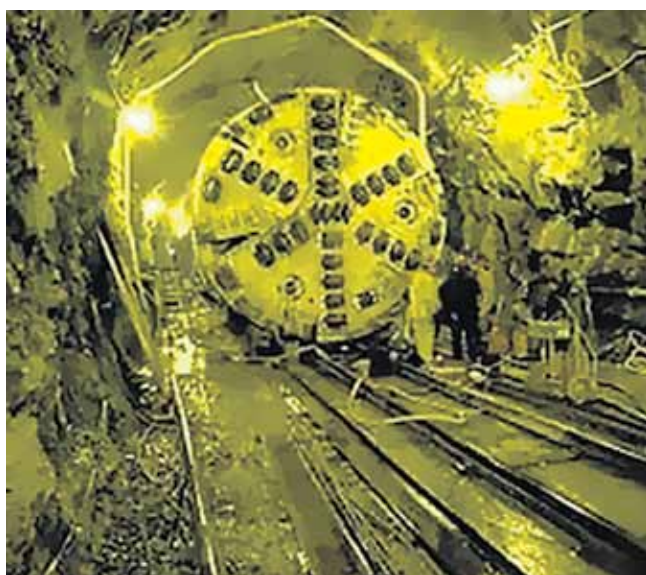
Рис. 4. Буровая туннельная машина в Западном туннеле водоснабжения Бостона. https://files.engineers.org/file/ACECMA-EEAC-MWRA-Nov-2018.pdf
