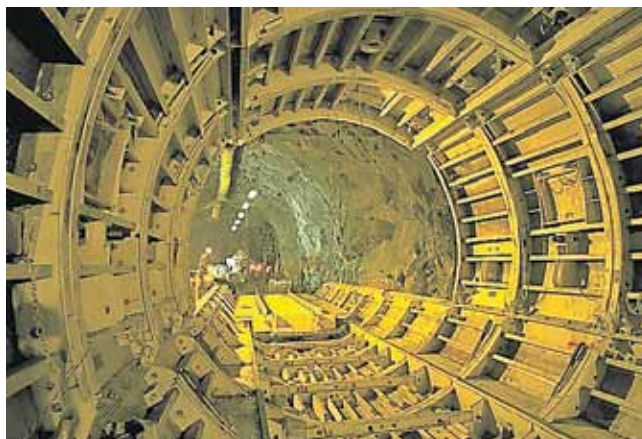
Рис. 5. Установка опалубки в Западном туннеле. http://www.mwra.com/04water/html/mwwst.html
