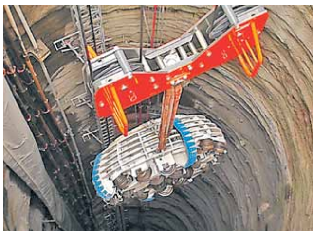
Рис. 8. Спуск режущей головки буровой туннельной машины по стволу доступа.
