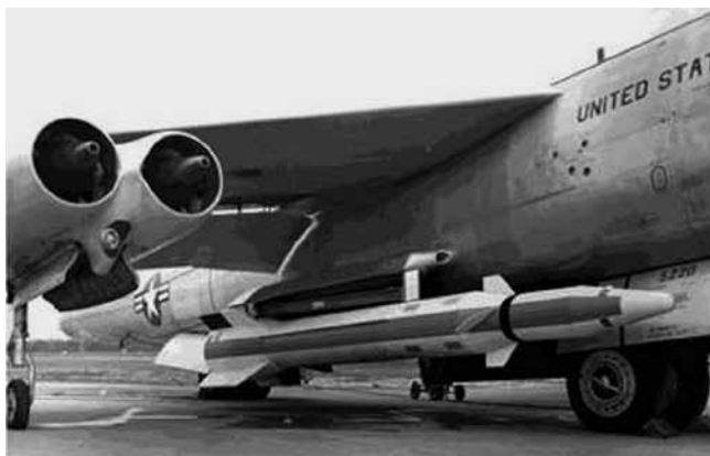
Американская опытная ракета Bold Orion под крылом бомбардировщика B-47B Stratojet
