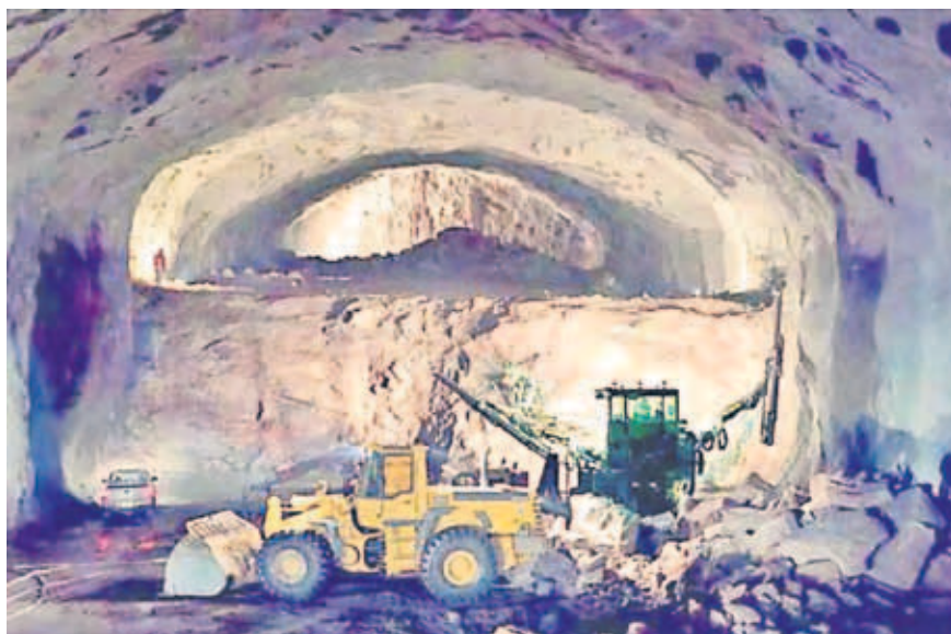
Рис. 5. Трёхстадийная экскавация полости установки Осет буровзрывным способом. http://tunnel.no/wp-content/uploads/2014/01/Publication_15.pdf
