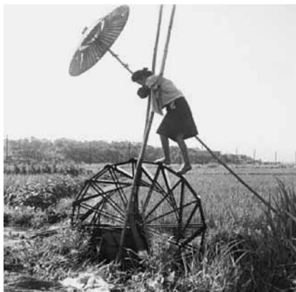
д) Колёсная подача воды для поливки небольших участков земли в Японии. http://www.waterencyclopedia.com/Po-Re/Pumps-Traditional.html
