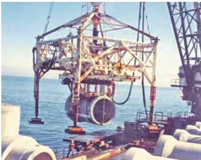
Рис. 5. Строительство с баржи вертикального ствола комплекса очистки сточных вод Сан-Диего
