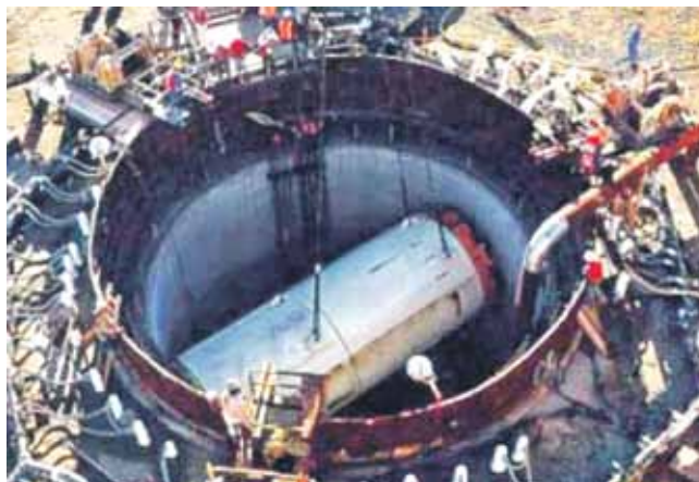
Рис. 6. Спуск буровой туннельной машины в ствол сброса воды
