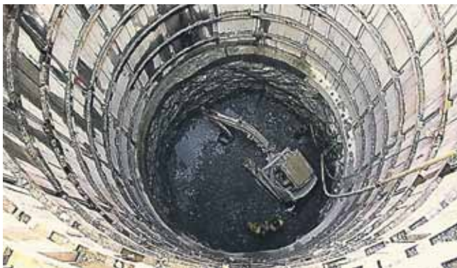
Рис. 10. Строительство одного из стволов системы туннелей и резервуаров Чикаго
