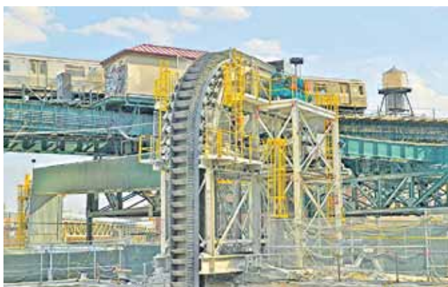
Рис. 12. Ленточный конвейер (фирмы Роббинс) в вертикальном стволе
