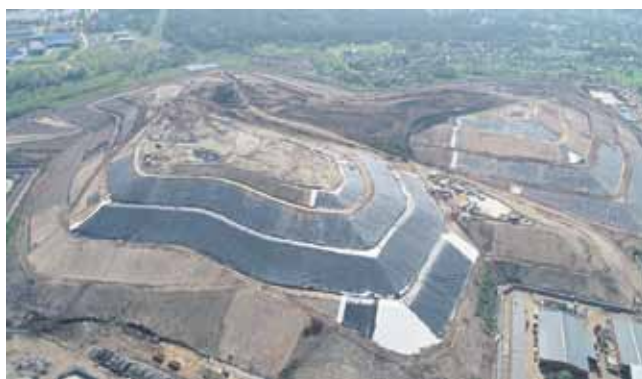
Рекультивация мусорного полигона в Кучине
