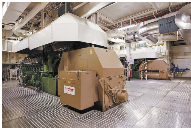
Газодизель 12VDZD-1000-125 с генератором и «Грибком» вытяжной вентиляции
