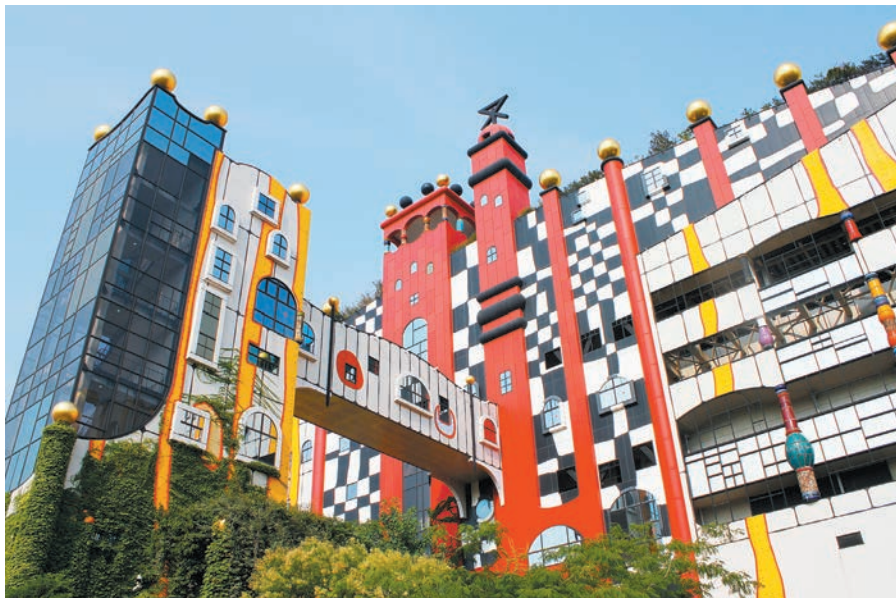
Завод по очистке сточных вод в г. Осака (Япония)
