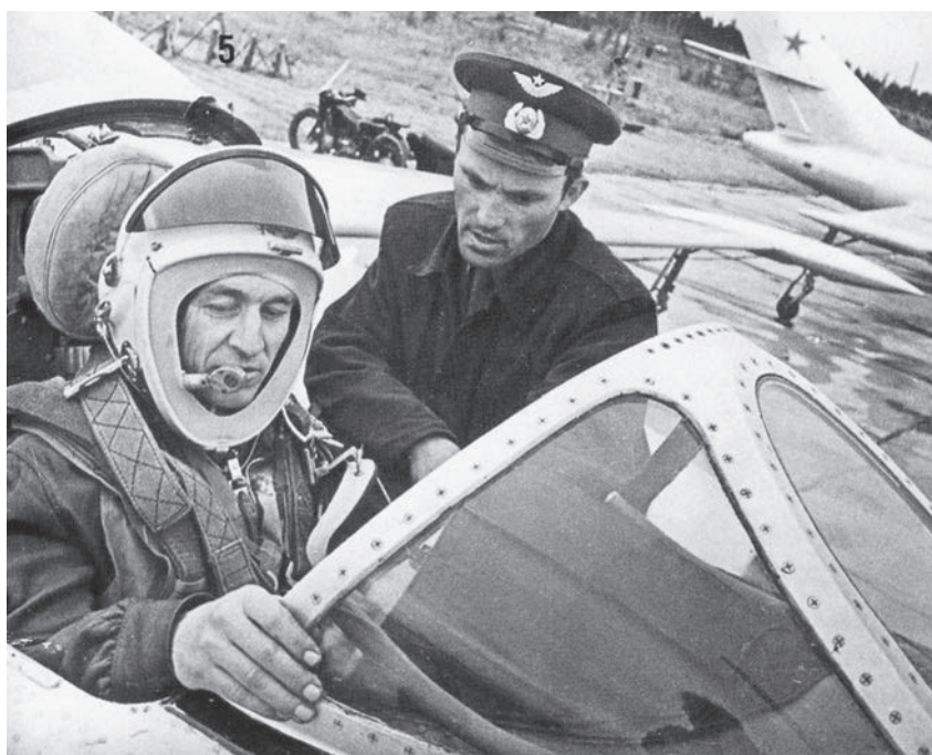
Летчик в высотно-компенсирующем костюме ВКК-3 с гермошлемом ГШ-4 в кабине Як-25РВ
