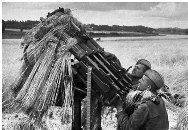
Из-за провала с производством зенитных пушек атаки Люфтваффе отбивались в основном счётверёнными пулемётами (установка М-4)
