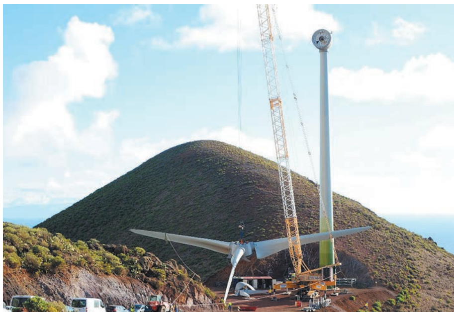
Монтаж ветрогенератора
