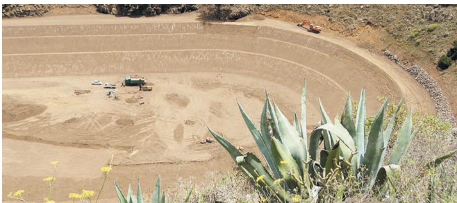
Строительство нижнего водохранилища
