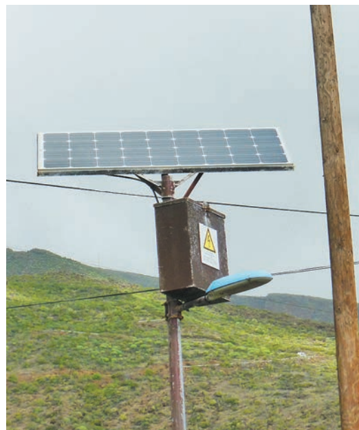
Фонарь уличного освещения с питанием от солнечной батареи
