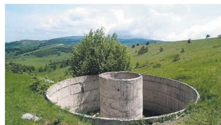
Бетонное основание, что осталось от Крымской ВЭС
