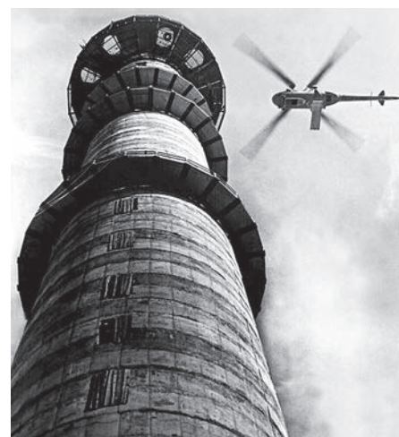
Вертолёт Ми-4 поднимает строительный груз
