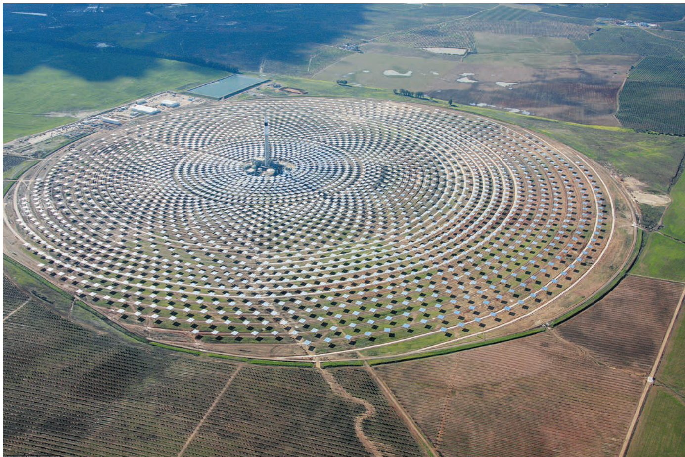
Гелиоэлектростанция концентраторного типа Гемосолар (Gemasolar) в Испании недалеко от Севильи
