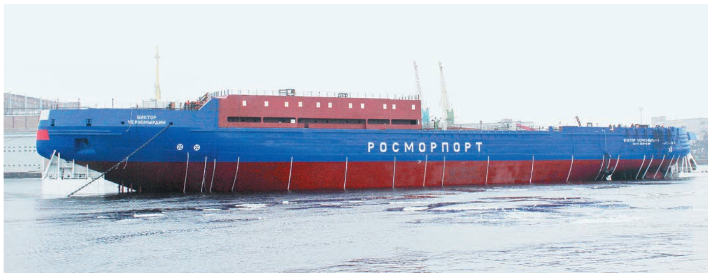
Спущенный на воду 30 декабря 2016 г. корпус ледокола «Виктор Черномырдин»
