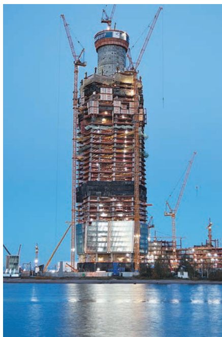
Строительство «Лакта-центра» — питерской «Кукурузы»
