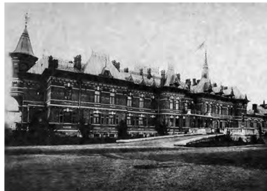
Беловежский императорский дворец. Северный фасад. 1894 г.
