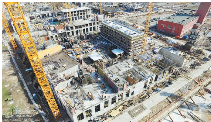
ЗИЛ превратился в огромную строительную площадку
