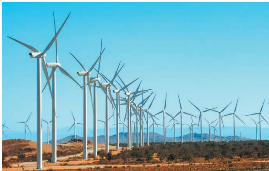
Самая крупная наземная ветряная электростанция в США — ALTA WIND ENERGY CENTER
