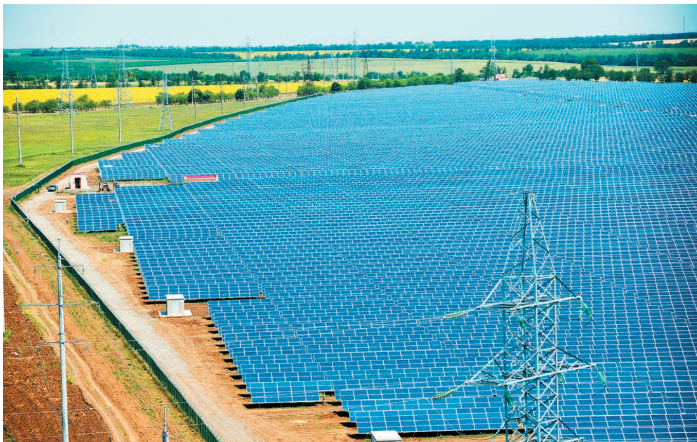
Солнечная электростанция под Арцизом в Одесской области
