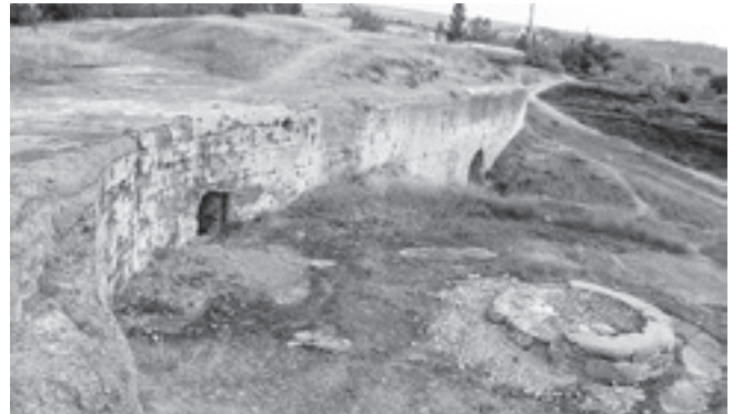
Батарея № 16 на Северной стороне
