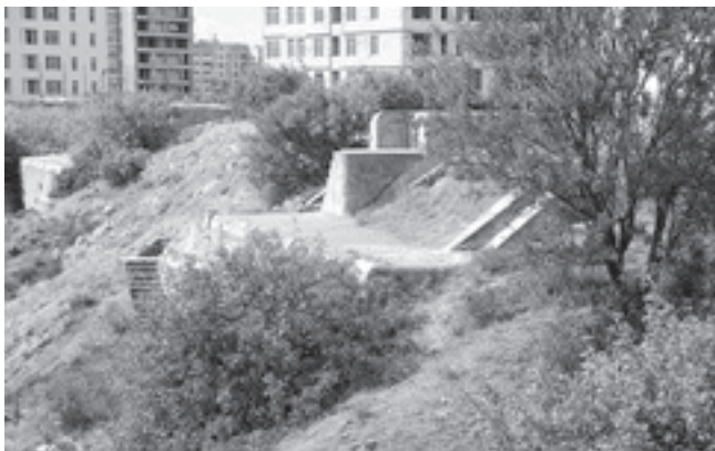
Бетонный массив 15-й батареи
