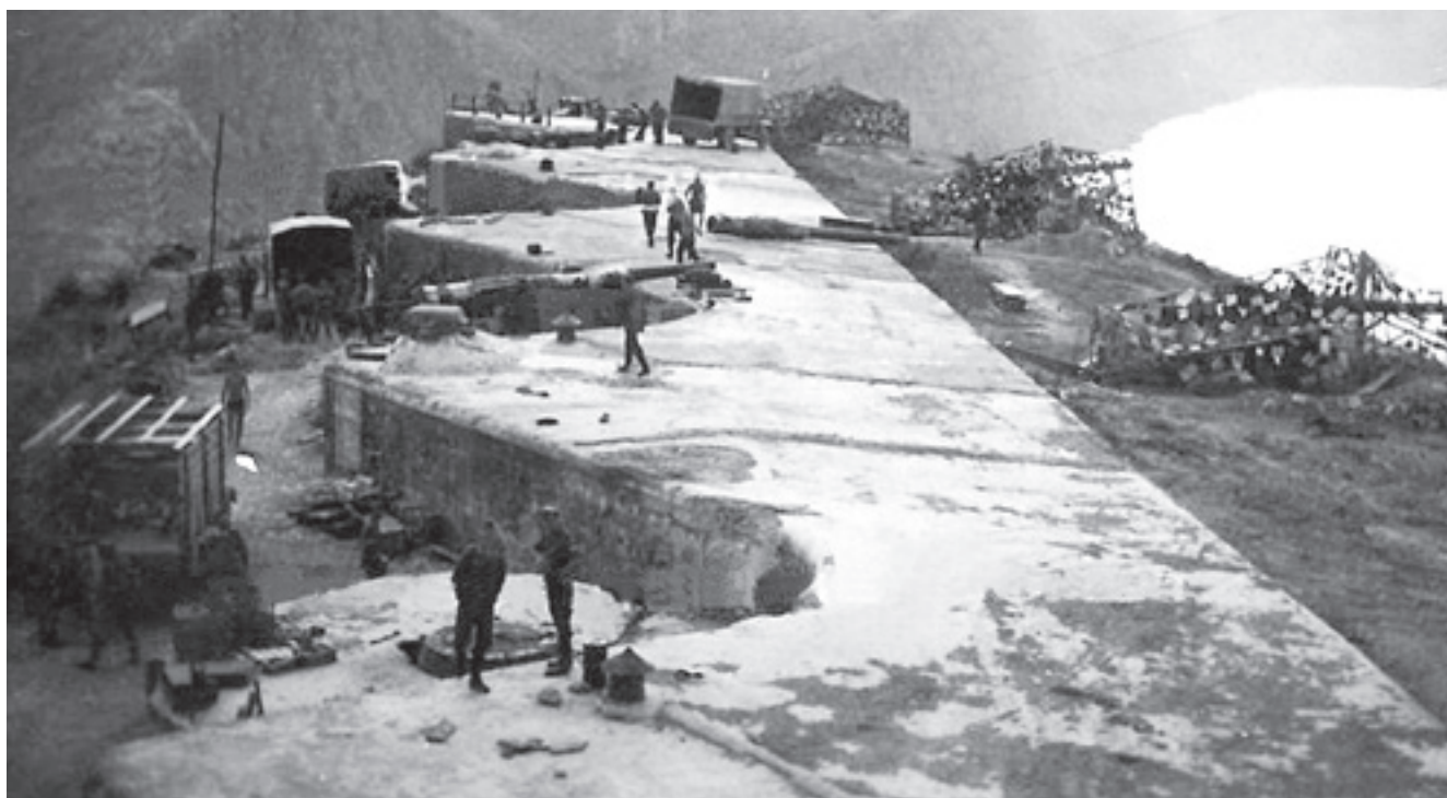
11-дюймовая батарея № 19 в районе хутора Богушевского северо-западнее мыса Фиолент. Справа стоят закамуфлированные французские 155-мм орудия, использовавшиеся немцами в береговой обороне. 1942 г.
