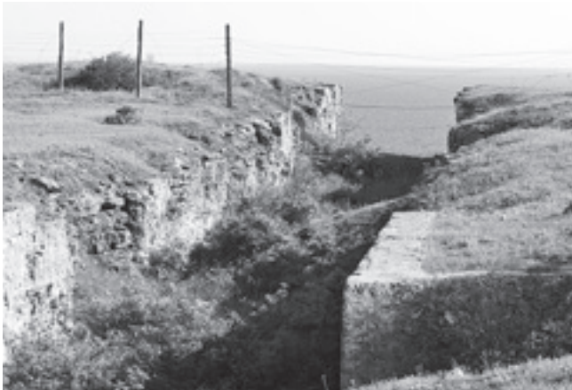
Оборонительные рвы 19-й батареи
