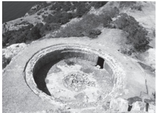
Бетонный дворик 152-мм орудия Канэ на 22-й батарее
