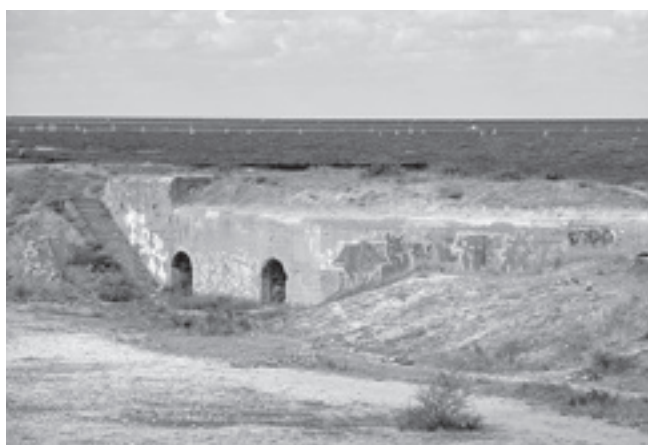
Бетонный массив с погребями 23-й батареи
