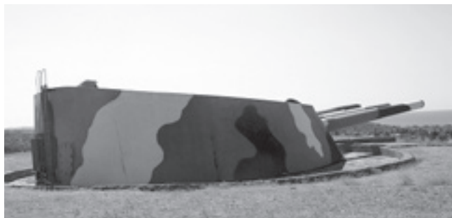
305-мм башня МБ-3-12ФМ на 30-й батарее. Вид сбоку
