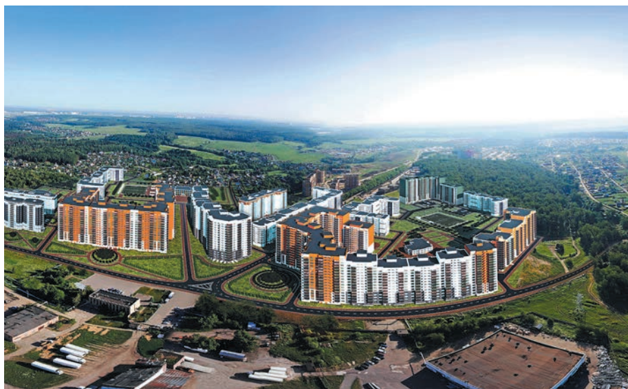
«Новая Москва» на законно экспроприированной земле
