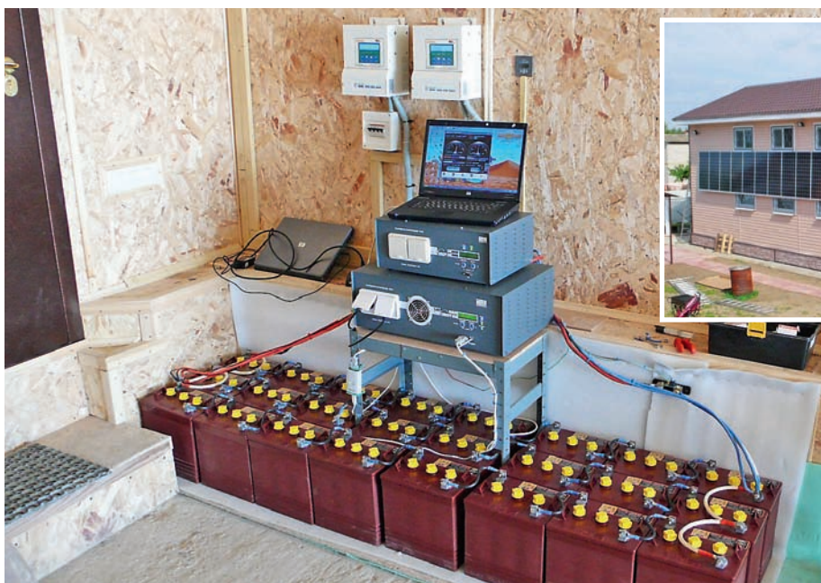
Система собрана и тестируется. Сверху вниз: два контроллера СП, стабилизатор напряжения, инвертор, АКБ. Как видим, эта система более мощная, так как предназначена для более крупного сооружения (оно на врезке)
