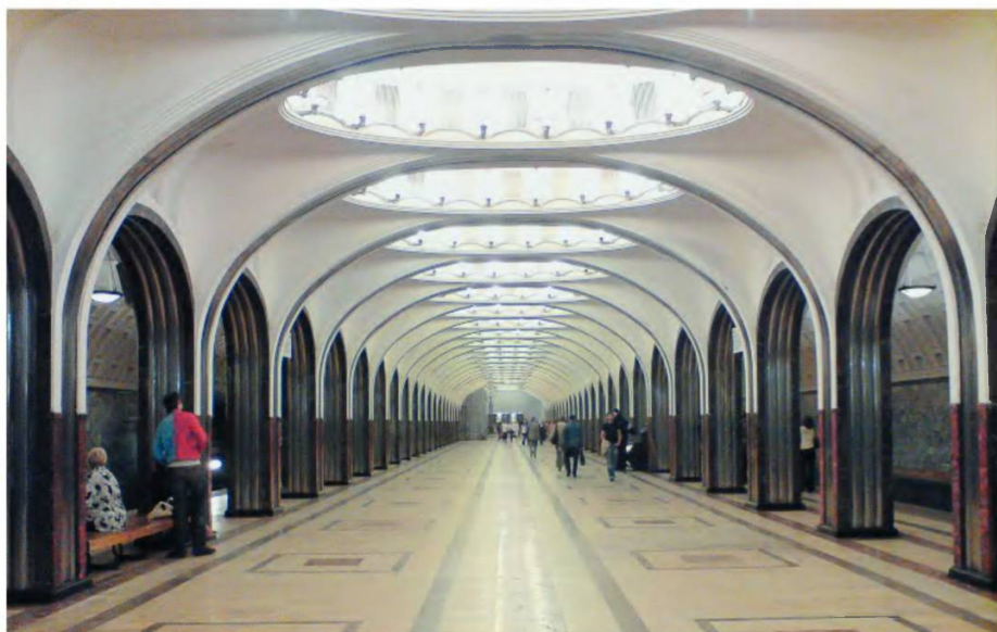
Станция Московского метрополитена «Маяковская». Хорошо видна отделка колонн и сводов нержавеющей сталью
